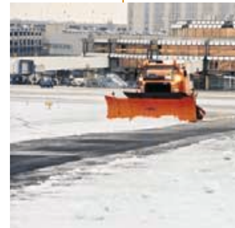
Het vrijhouden van de banen gebeurt door de cel 'Winter Operations' van de Luchthaveninspectie. In eerste instantie gebeurt dit door sneeuwruimers en mechanische hitte-aggregaten.
