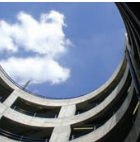
De nieuwe Front Park 1 parking brengt een gevoelige uitbreiding van het aantal parkeerplaatsen.
